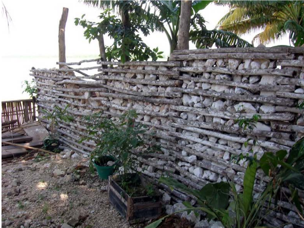
Foto 27. Técnica de pretil, aun utilizada para construir paredes sobre plataformas de piedra.
