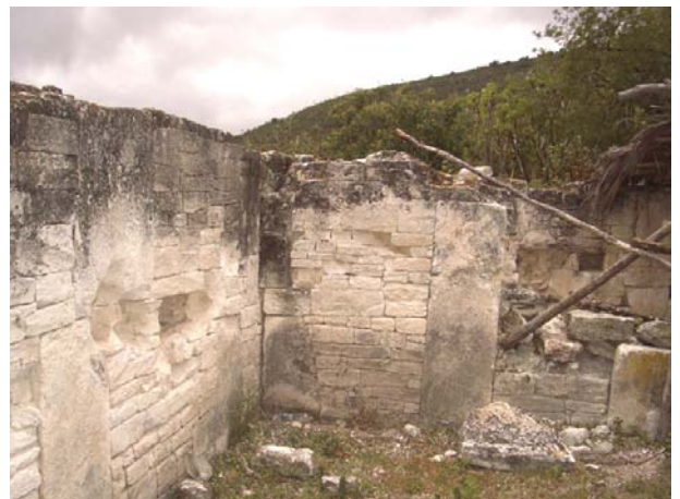
La esquina Sureste del patio. Las fachadas se enchaparon con bloques de diversos tamaños
