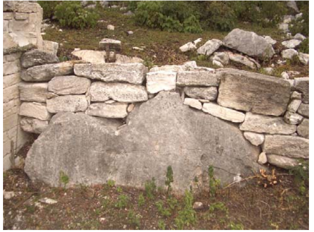
Muro Este del patio (adición reciente).
