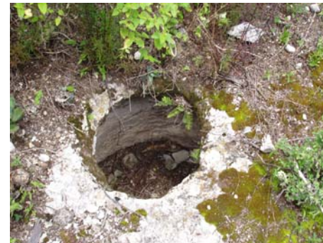
Apertura de un sótano en la cima del Cerro Ndaxagua
